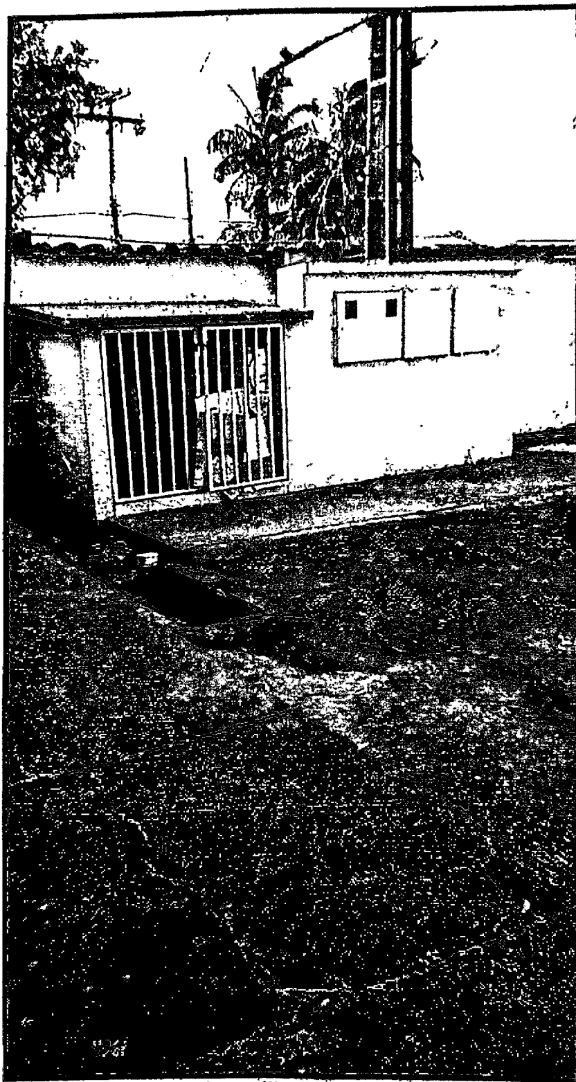
Fig.12 - Abrigo de resíduos sólidos domésticos e calçada rachada
