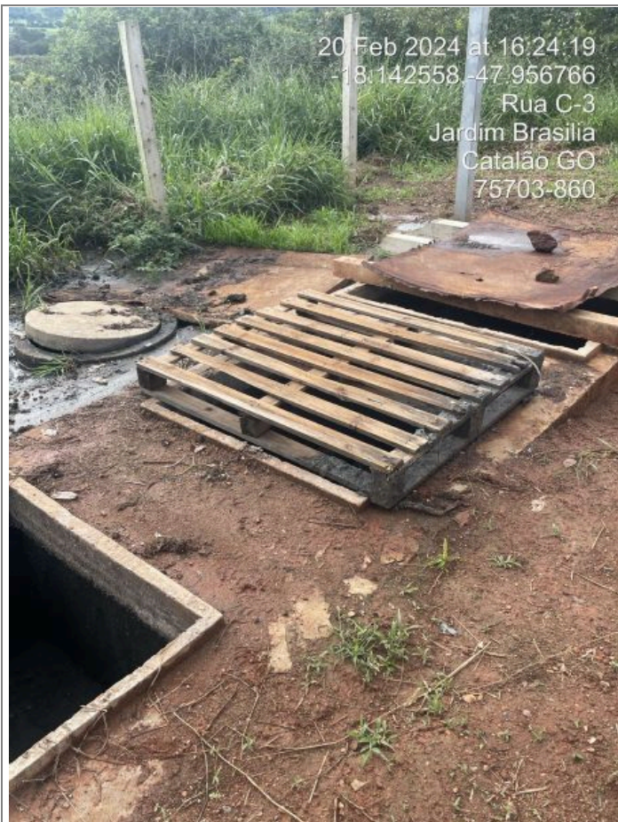
Foto 43: Estação Elevatória de Efluentes - EEE - Esgoto bruto à céu aberto.
