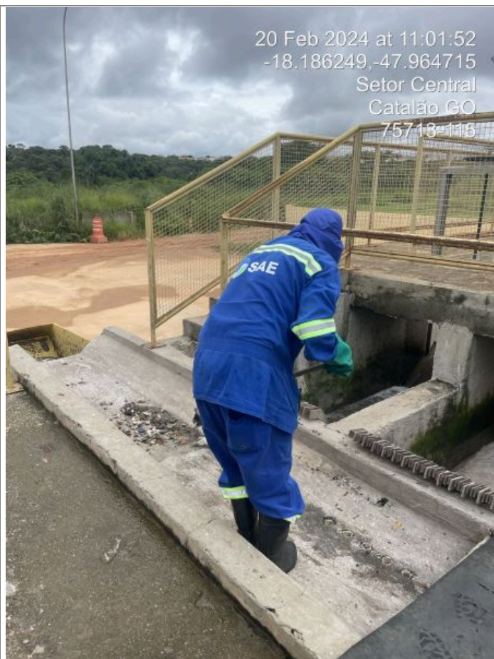
Foto 12: Válvula de escape / bypass para envio do efluente bruto diretamente às lagoas de estabilização.
