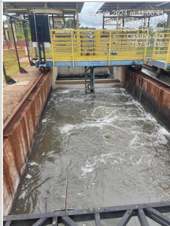
Foto 13: Sistema de limpeza improvisado pós tratamento preliminar.
