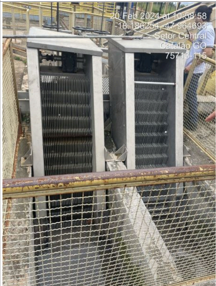
Foto 10: Limpeza manual do gradeamento.
