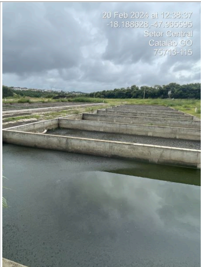
Foto 32: Disposição de lodo biológico no solo.
