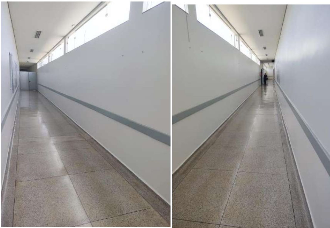
ÁREA COMUM: PINTURA DE BATE MACA DOS CORREDORES PRINCIPAIS
