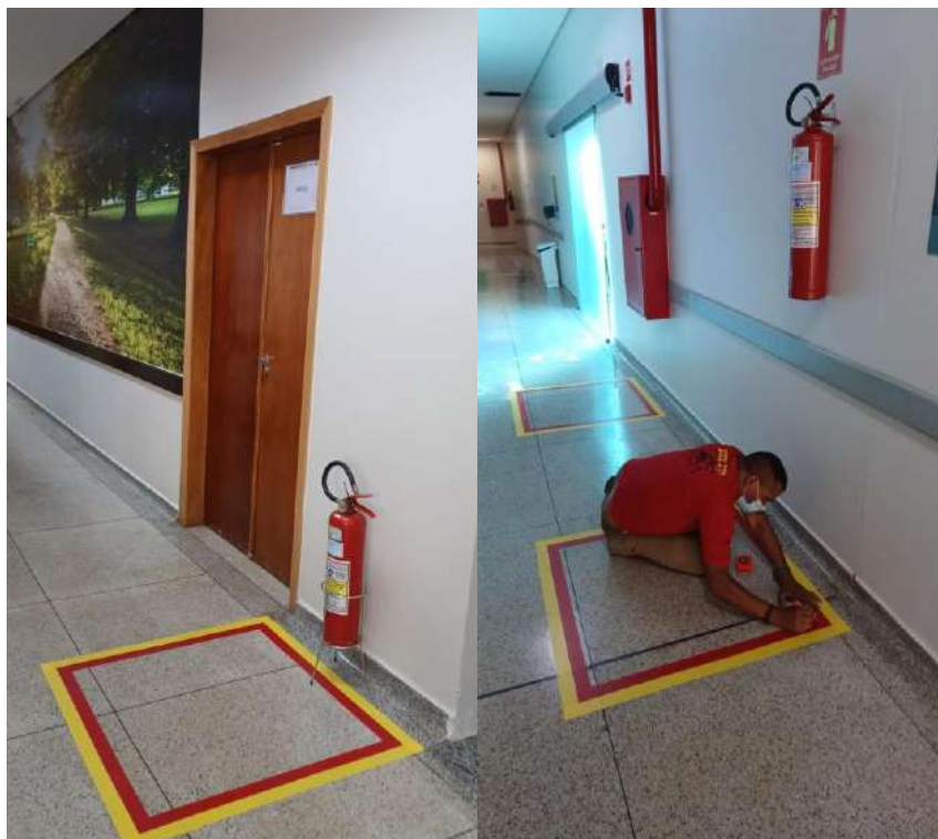
ÁREA COMUM: ADEQUAÇÃO DO SISTEMA DE PREVENÇÃO E COMBATE A INCÊNDIO
