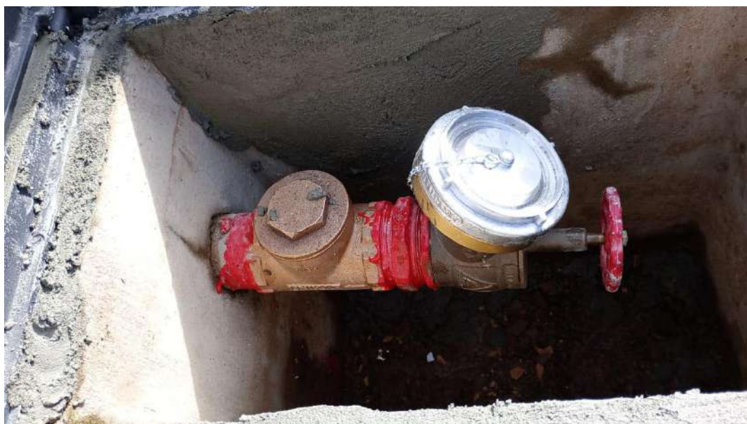
ÁREA COMUM: ADEQUAÇÃO DO SISTEMA DE PREVENÇÃO E COMBATE A INCÊNDIO
