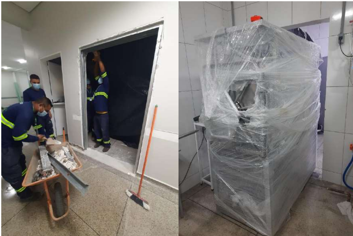
CME: ABERTURA DE VÃO PARA PASSAGEM DE NOVO EQUIPAMENTO DE AUTOCLAVE
