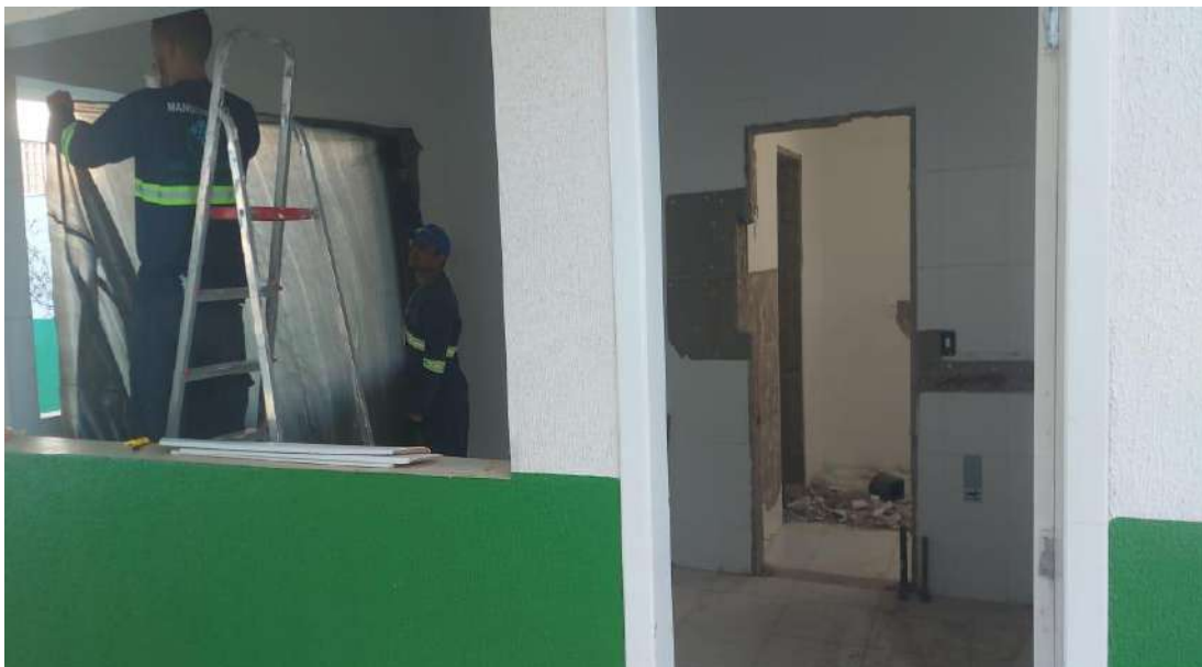
ÁREA EXTERNA: ADEQUAÇÃO DE AMBIENTE EXTERNO PARA INSTALAÇÃO DE NOVO REPOUSO DE ENFERMGEM
