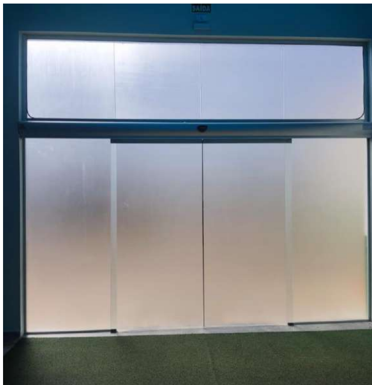
RECEPÇÃO CENTRAL: INSTALAÇÃO DE NOVA PORTA DE VIDRO AUTOMÁTICA
