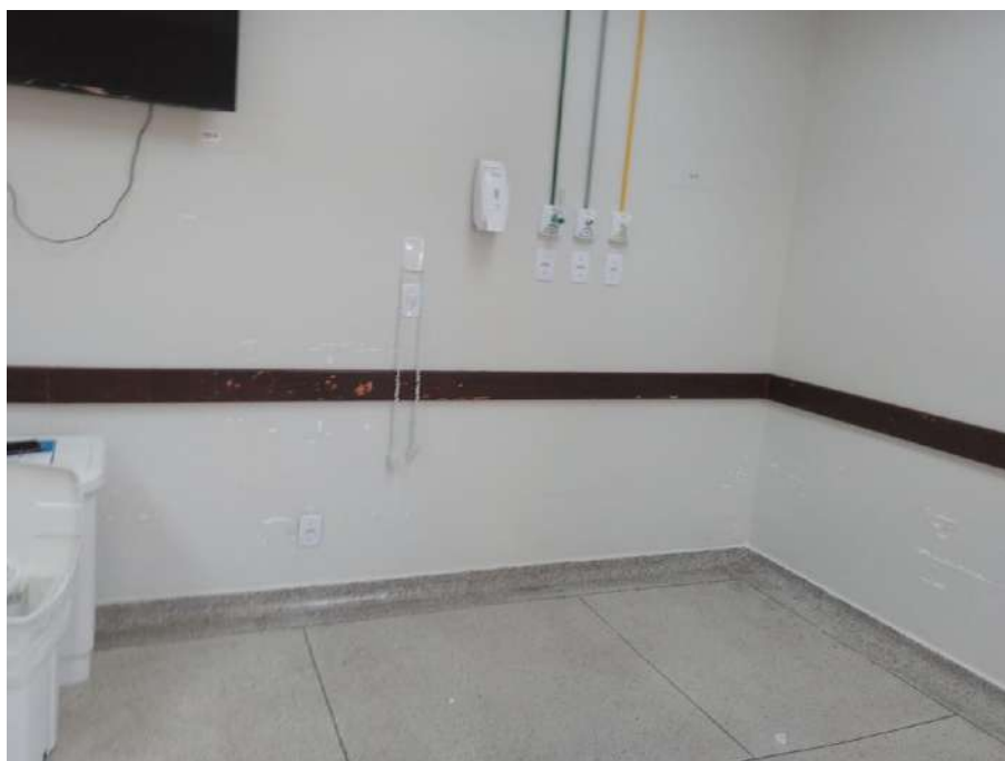
ENFERMARIAS: REVITALIZAÇÃO DE PINTURA EM TODOS OS LEITOS DE ENFERMARIA
