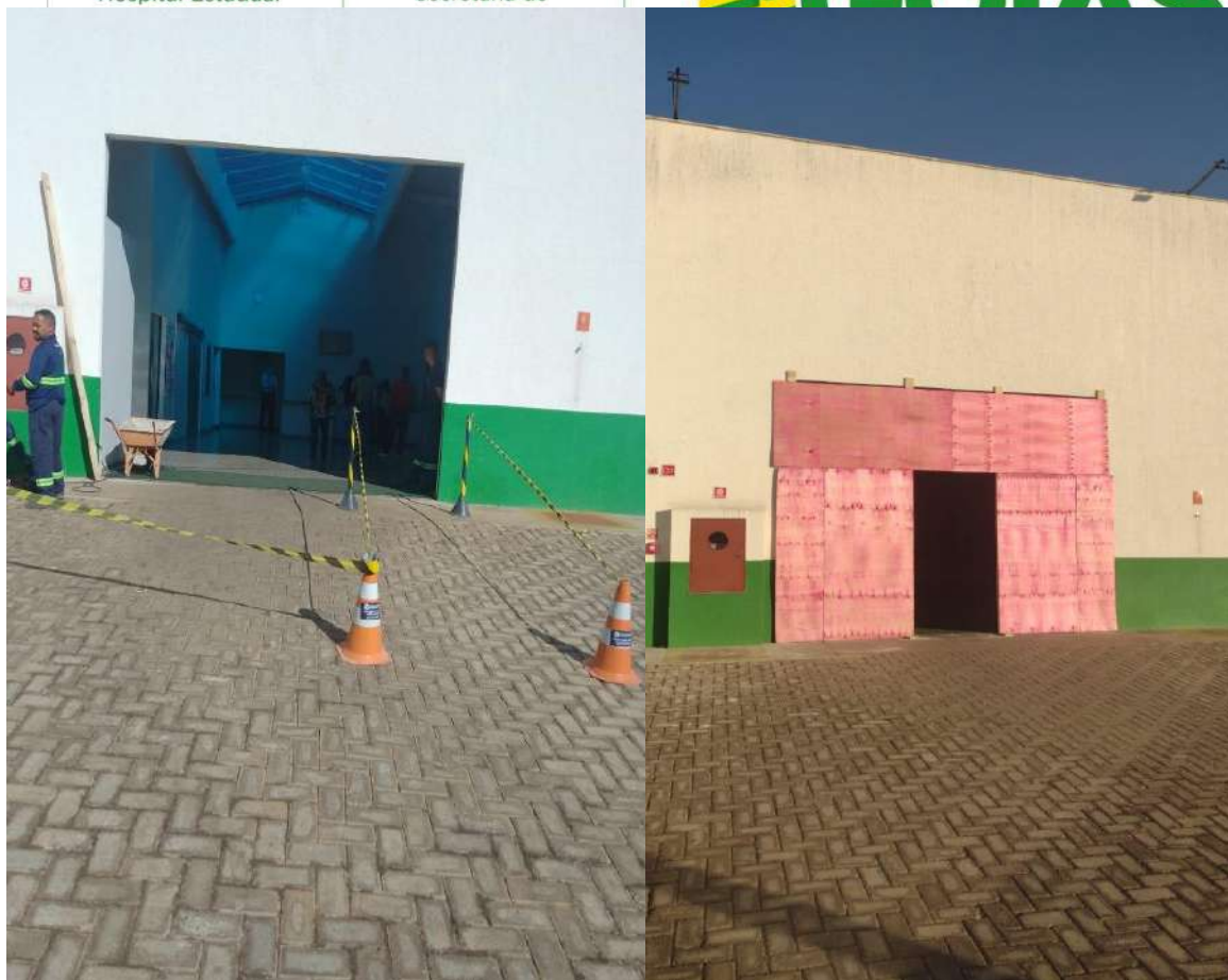
RECEPÇÃO CENTRAL: INSTALAÇÃO DE NOVA PORTA DE VIDRO AUTOMÁTICA
