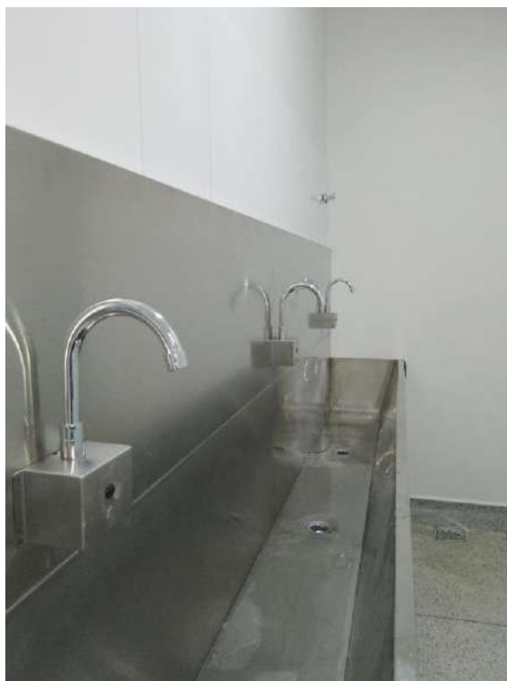
CENTRO CIRÚRGICO: INSTALAÇÃO DE TORNEIRAS AUTOMÁTICAS
