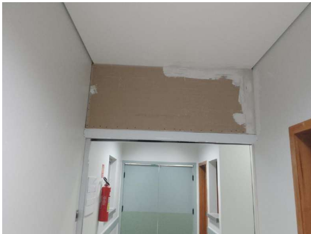
CENTRO CIRÚRGICO: FECHAMENTO DE VÃO COM ESTRUTURA EM DRYWALL ACIMA DA PORTA DE VIDRO AUTOMÁTICA
