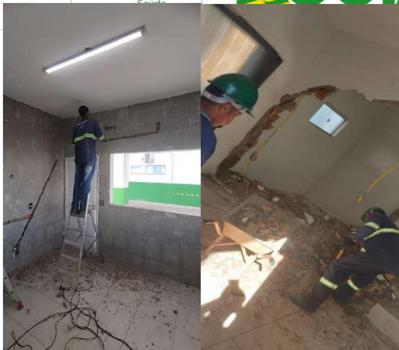
ÁREA EXTERNA: ADEQUAÇÃO DE AMBIENTE EXTERNO PARA INSTALAÇÃO DE NOVO REPOUSO DE ENFERMGEM
