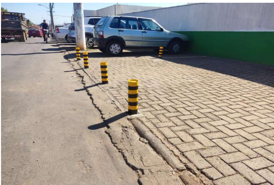
ESTACIONAMENTO EXTERNO: BLOQUEIO DE VAGAS PROXIMO AO PORTÃO DE ACESSO DE CARGAS/DESCARGAS
