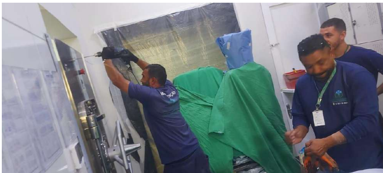
CME: INSTALAÇÃO DE CHAPA INOX PARA VEDAR VÃO DA AUTOCLAVE
