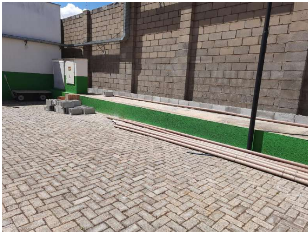
ÁREA EXTERNA: EXECUÇÃO DE NOVA INFRAESTRUTURA HIDRÁULICA PARA ABASTECIMENTO DOS RESERVATÓRIOS DE ÁGUA
